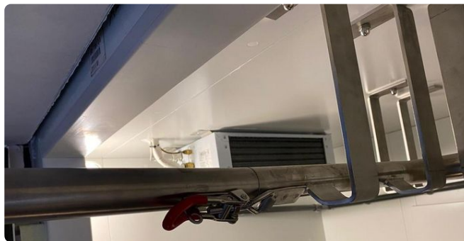
WANDDURCHFÜHRUNG Kupplung mit Spannverschluss an der Rohrverlängerung nach außen
