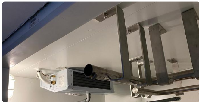
EINBAU Rohrbahn unter der Zelloberfläche, Deckenabhängiger mit 3-Loch-Platte
